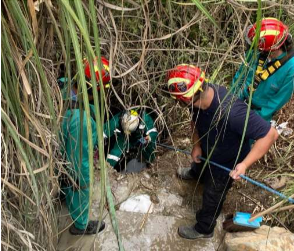
Fotografía 15, 16, 17 y 18. Limpieza en la quebrada
