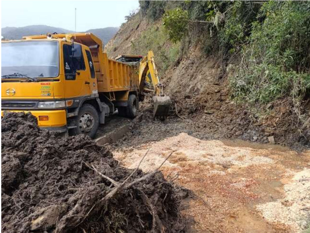
Fotografía 4. Limpieza de lodos en cunetas de agua para la carretera.
